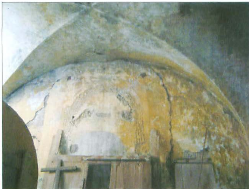
Parete Absidale interna della Chiesetta di S. Francesco, quartiere Carmine, Acireale
