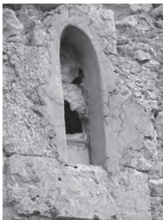
Fig. 17 - Particolare della monofora, esterno
