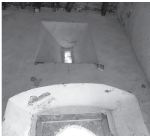
Fig. 18 - Particolare della monofora, interno
