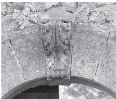
Fig. 9- Particolare della chiave di volta
