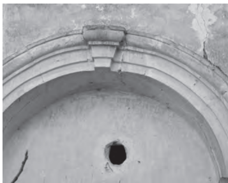
Fig. 12 – Chiave di volta dell'archivolto absidale
